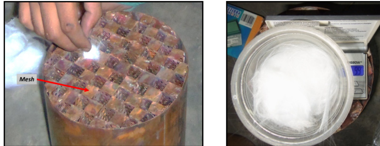
Gambar 1. Pemasangan glass wool pada DPF
