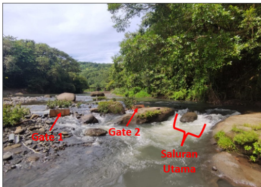
Gambar 3. Pembukaan katup 1 (gate 1 dan gate 2 ditutup)
