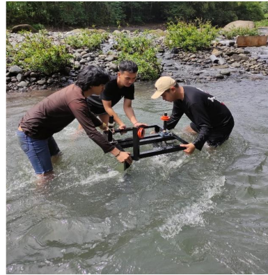
Gambar 6. Instalasi kincir air savonius vertikal
